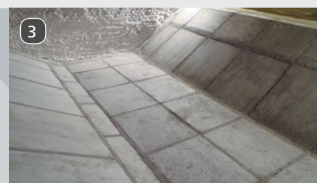
3 Ramp & bottom with precast shape Solera y rampa en pieza prefabricada
